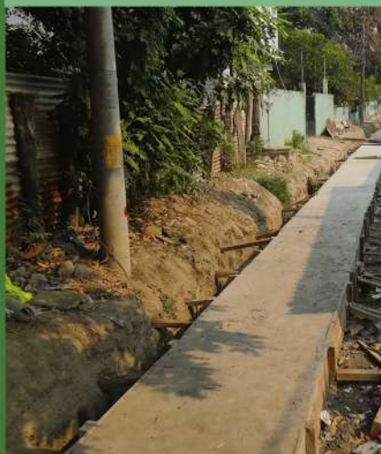
📍 Construcción del sistema de aguas lluvias de la colonia Honduras.
