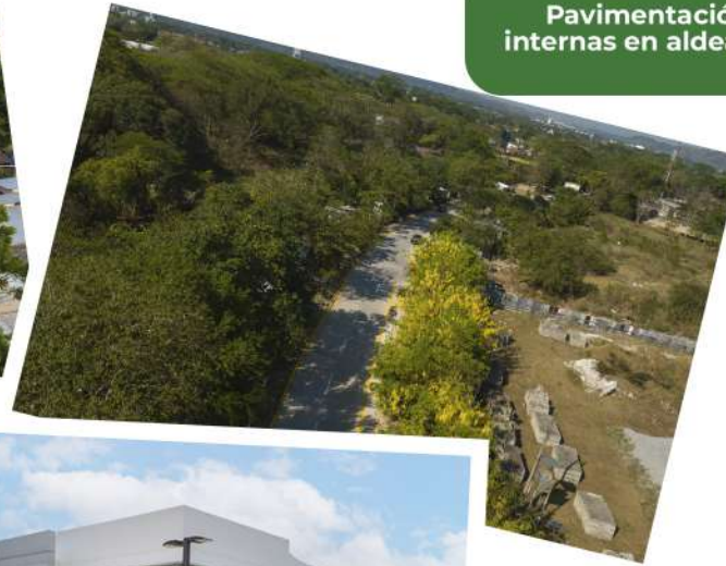
Pavimentación de la calle sobre bordo sur Río Santa Ana.
