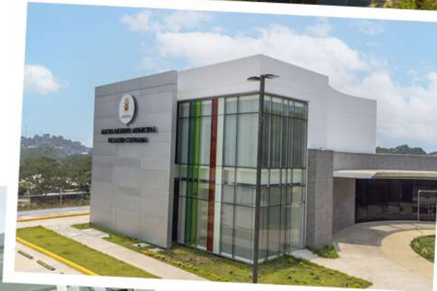
Construcción del Macro Distrito Municipal de Salud Cofradía.
