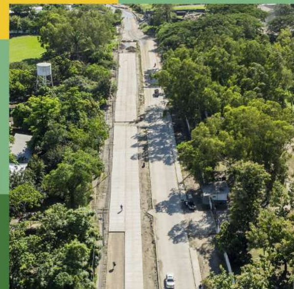
📍 Pavimentación de la segunda trocha, tercera avenida S.E. desde la 33 calle hasta colonia Providencia, sector Chamelecón.
