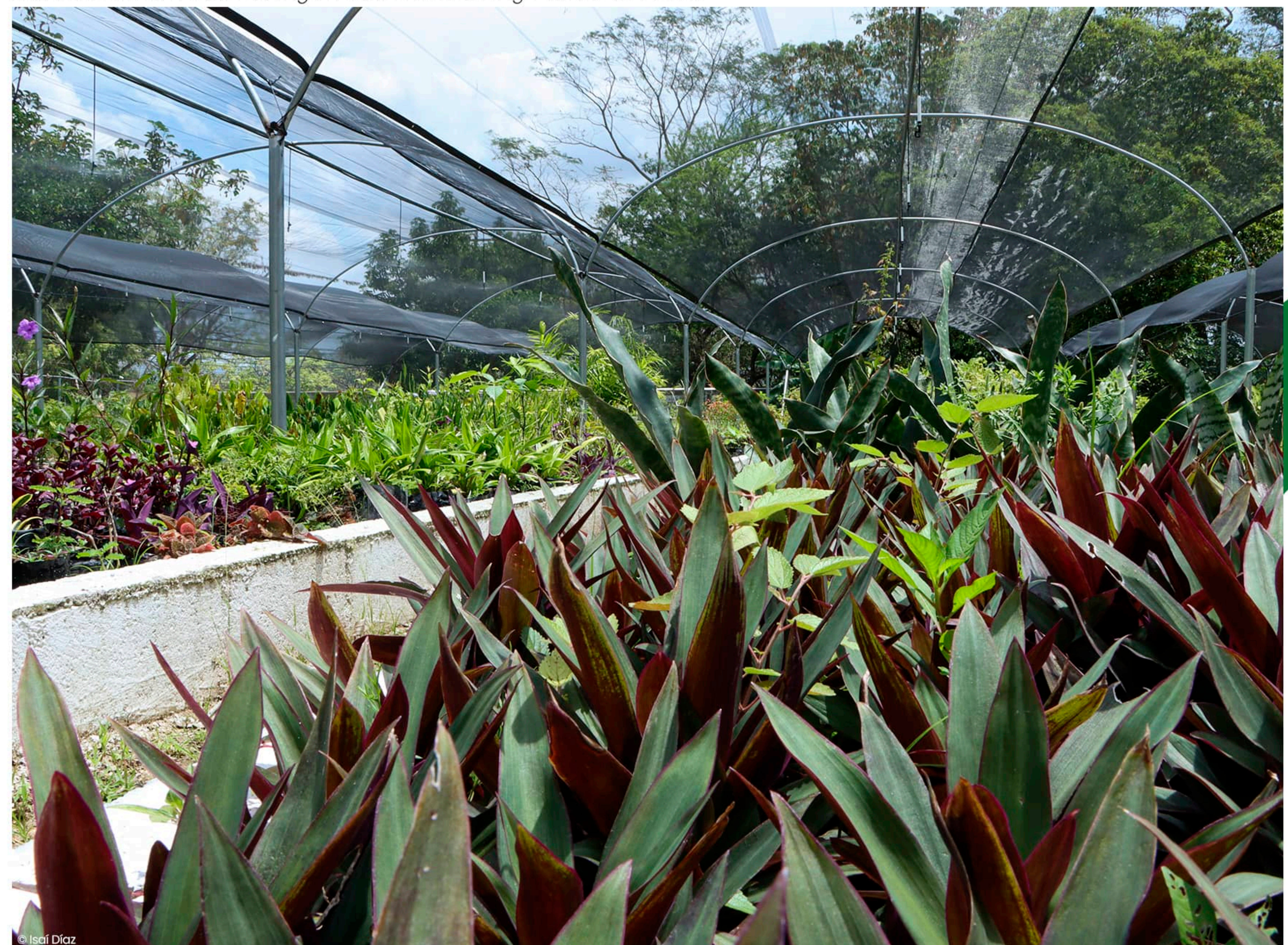
Construcción del sistema de riego sistematizado en Mega Vivero Santa Ana.
